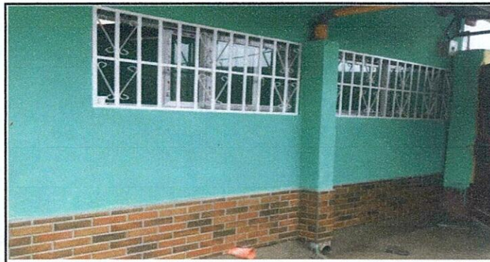
Pintura en interior y exterior en ambas aulas finalizado en su totalidad
