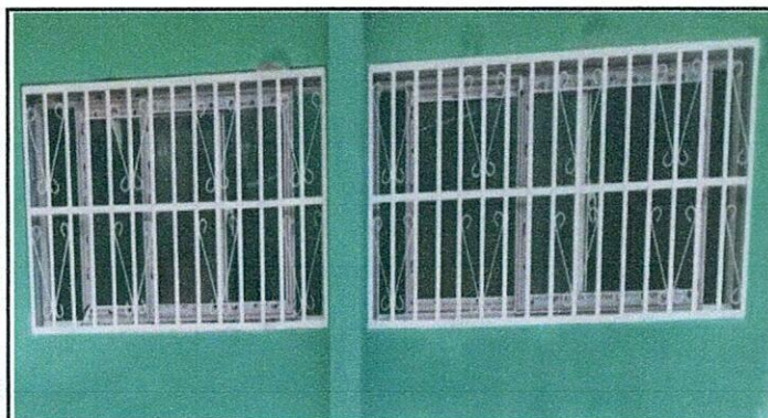
Área que fue remozada ventanas de pvc finalizada
