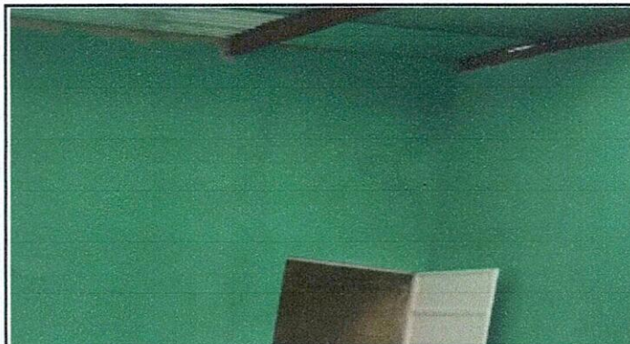
trabajo de altura de pared finalizado
