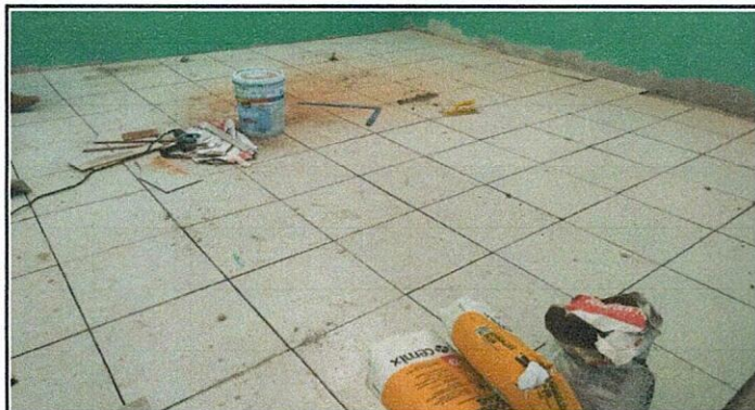
mejoramiento de piso finalizado
